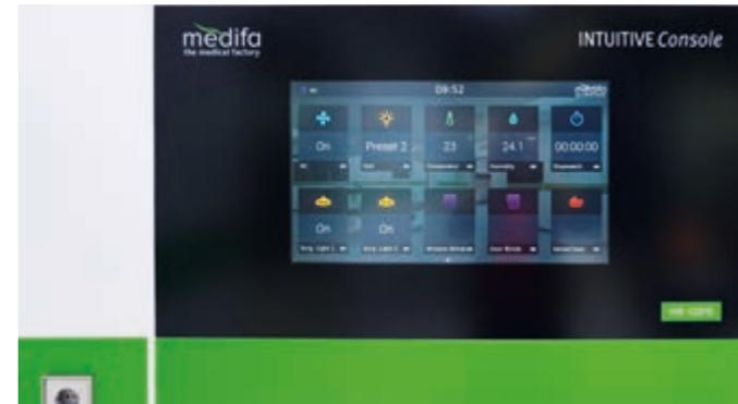
Panneau de commande tactile centralisé de la salle d'opération : Console INTUITIVE intégrée affleurante
