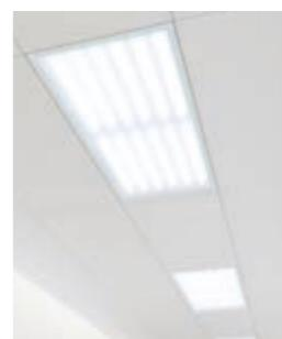
Pièce d'hygiène avec plafond à caissons métalliques en grille standard 600 x 1200 mm, avec éclairage LED encastré
